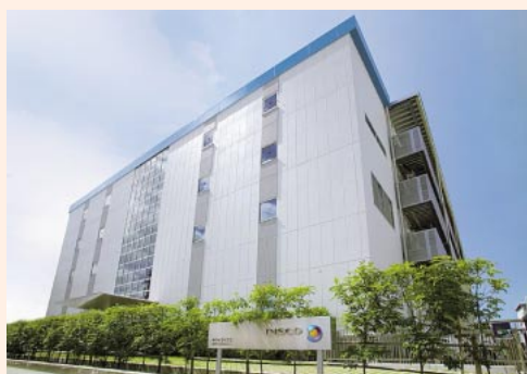
呉工場精密加工ツール棟外観
