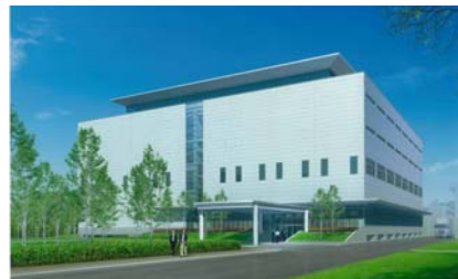
DISCO 茅野工場 I期工事 ダイイチコンポーネンツ 茅野工場
